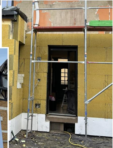
*Fassadendämmung mit Steinwolle Platten. Oben links im Bild ein Flachkanal der Lüftungsanlage.*
