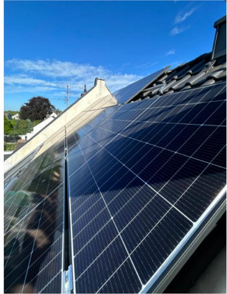
*Die selbst geplante Solaranlage mit 14 Modulen auf dem Dach.*
